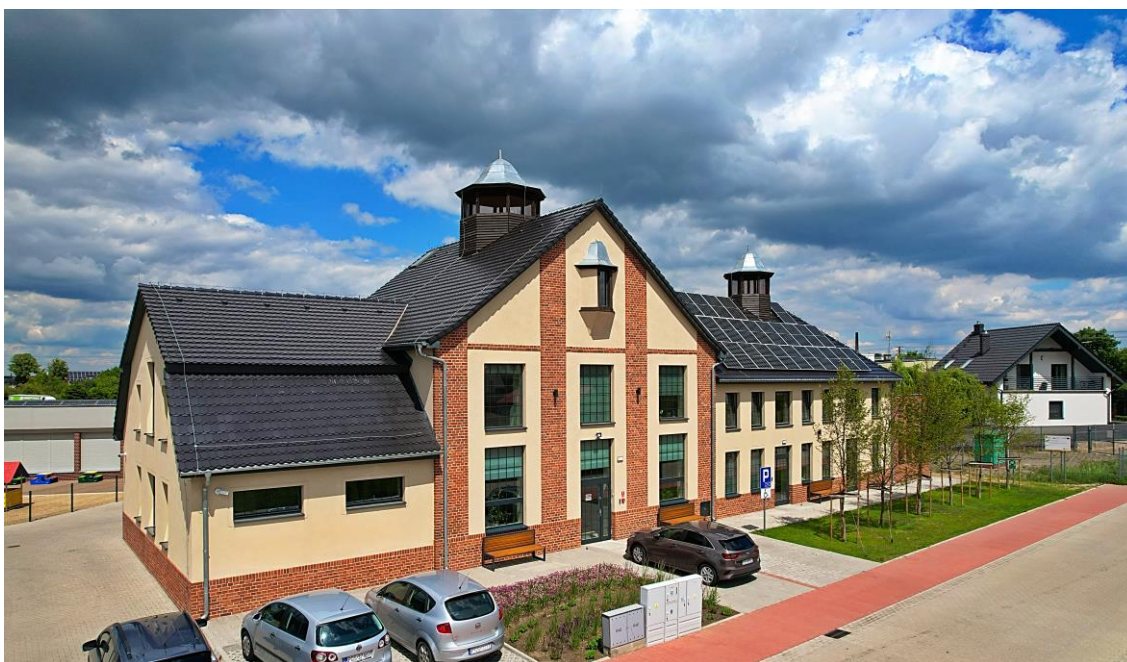
Rysunek 24. Zrealizowane przedsięwzięcie rewitalizacyjne – Stara Gazownia w Krobi
